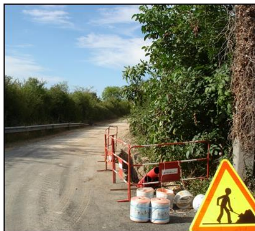
Travaux de raccordement au réseau local (Source : VALOREM)
